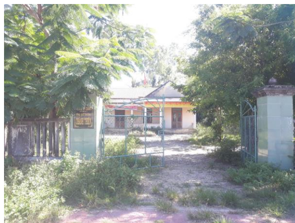
Hình 29. Trụ sở thôn Chánh Thiện
